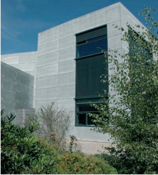
Woning en atelier Vaessen
